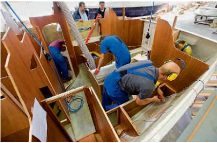
Vor Ort. Die Einbauten entstehen im Schiff, nicht als zeitsparende Module
